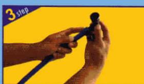
Masukkan fitting sampai ujung pipa menyentuh stopper fitting. Diamkan 2-5 menit, agar pipa mengikat fitting dengan sempurna.
