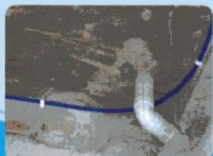
Pipa PEX jika digunakan untuk aplikasi di luar ruangan, terkena sinar matahari secara langsung atau tidak langsung, harus dibungkus dengan pembungkus dalam bentuk foam, tape atau isolasi. Pembungkus ini digunakan untuk melindungi pipa dari serangan Ultra Violet matahari yang dapat merubah struktur kekuatan pada pipa PEX.
