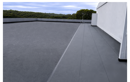
Dak Atap Kantor
