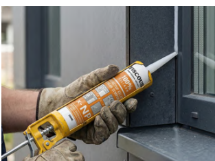
Instalasi Jendela Aluminium
