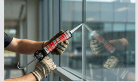
Instalasi Kaca Jendela Interior
