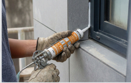
Instalasi Kaca Jendela Eksterior
